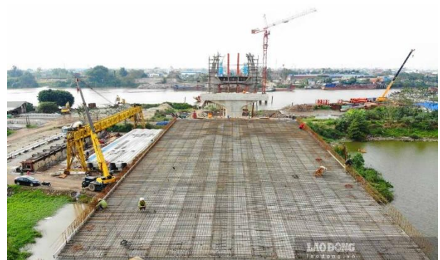
Cầu qua sông Đào nối từ đường Song Hào đến đường Vũ Hữu Lợi
